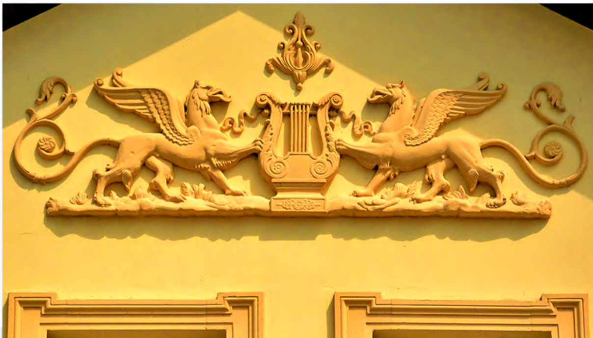
Gryfy na prywatnym domu przy ul. Polnej 9
