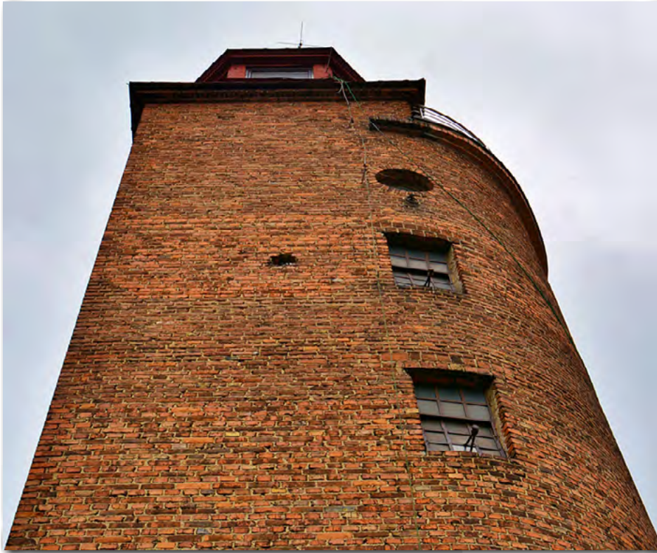
Widok na wieżę budynku straży pożarnej przy ul. Wyszyńskiego 7
