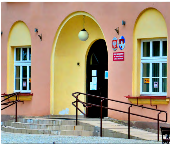
Szkoła podstawowa, zbliżenie na strefę wejścia do budynku
